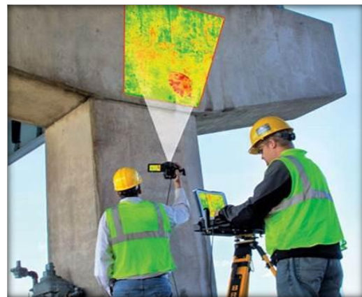
与建安单位开展合作，创新数字化技术应用场景，开展运维平台的基础架构搭建
