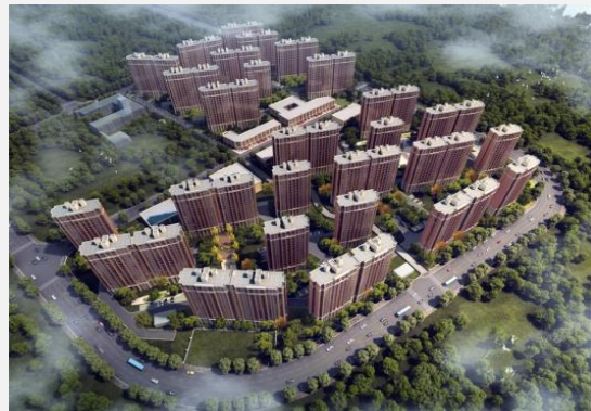
上海核建科创园建设项目
