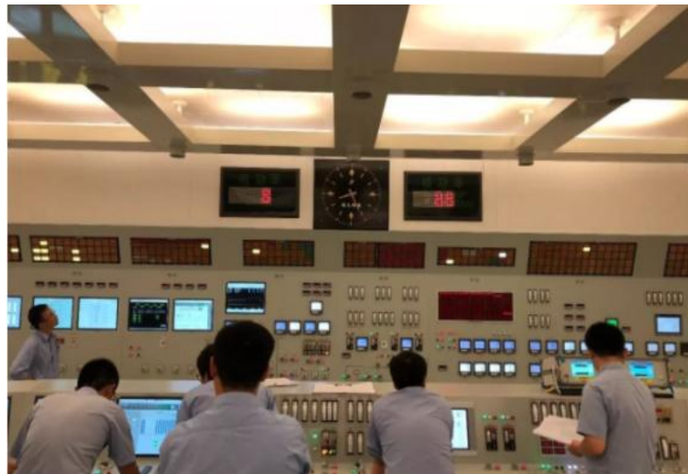
主控制室数字化改造“换脑”工程
