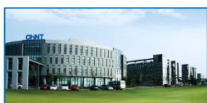
正泰电气总部·上海松江
