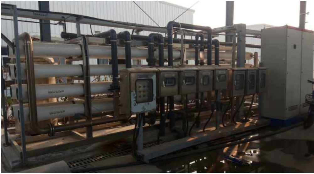
大丰项目污水处理设施中的中水回用系统
