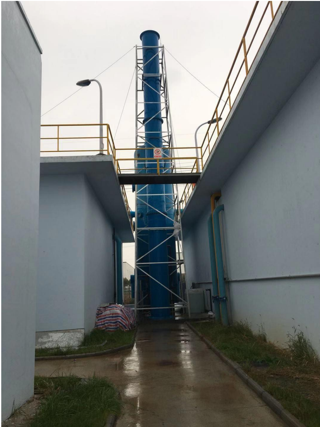
污水臭气净化装置用于污水站的臭气回收及除臭，减少对环境污染
