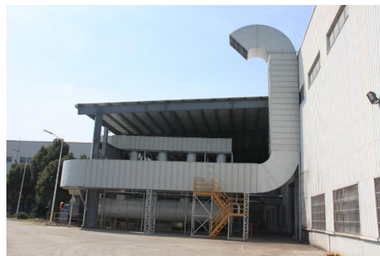
VOC 综合处理装置
