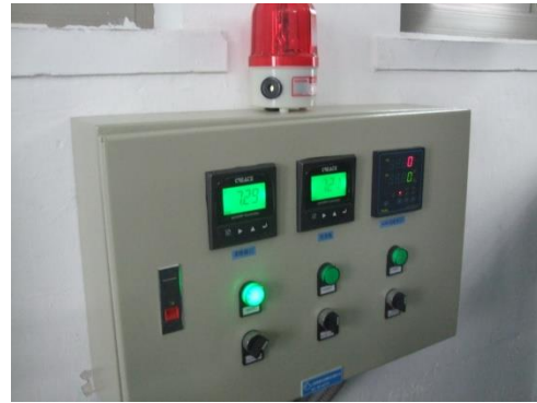
雨水泵站 PH 值在线监测仪
