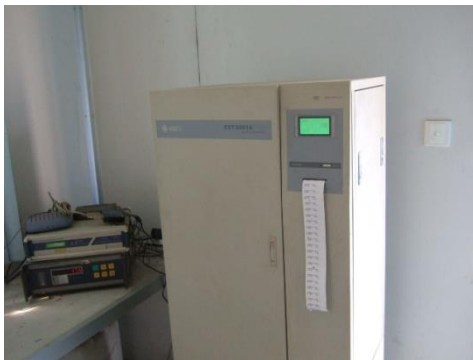
雨水泵站 COD 在线监测
