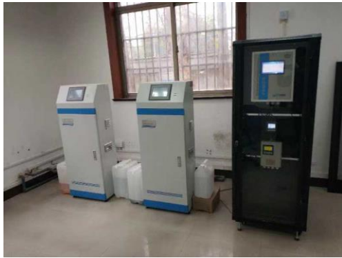
工业废水自动监控设施
