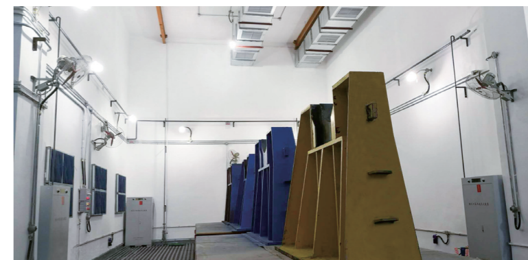
油漆漆雾收集净化系统 ▲
