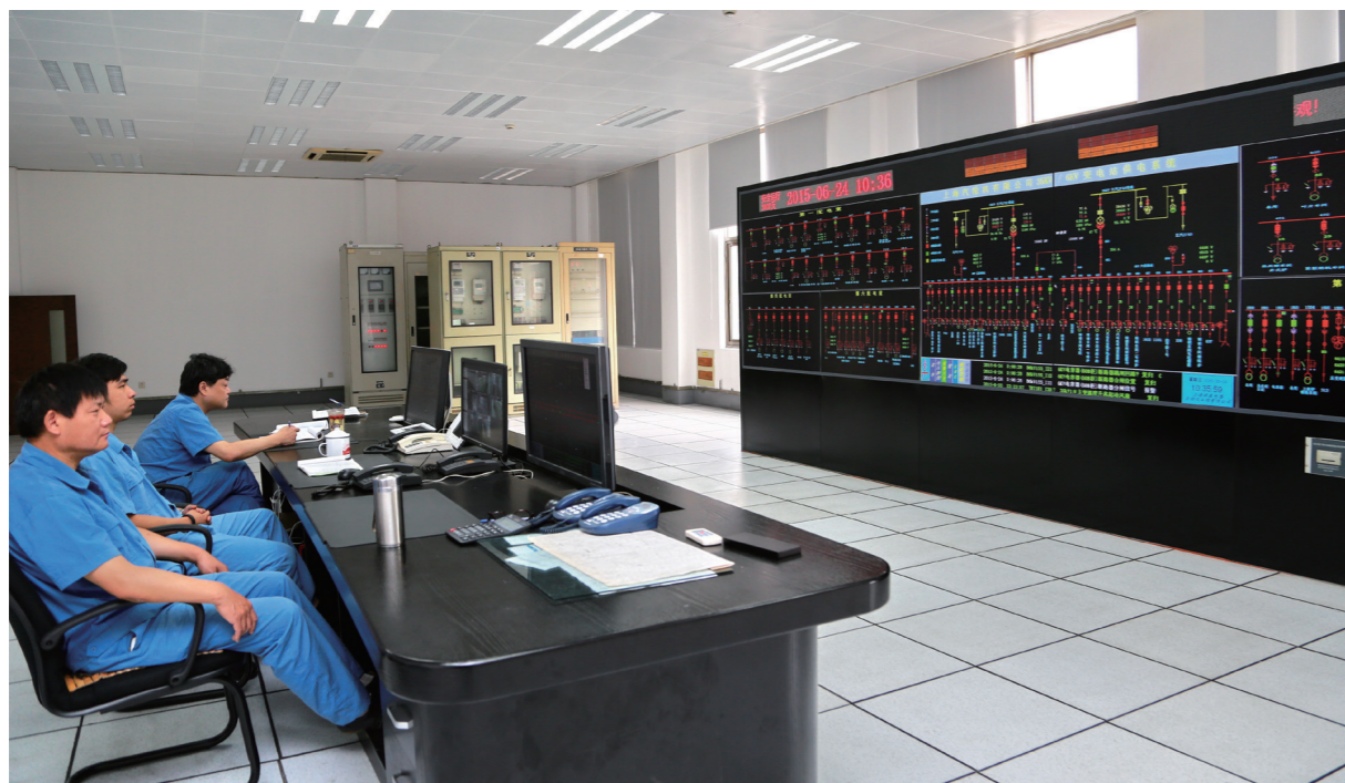
▲ 生产保障部电器控制中心
