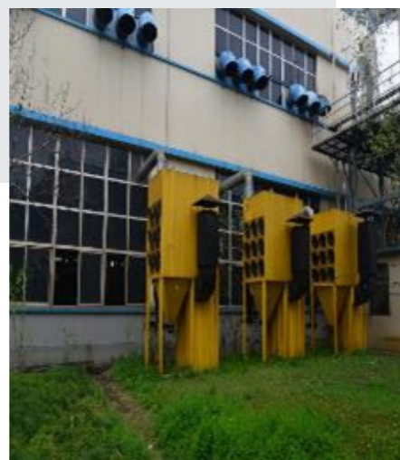
新增的焊接废气除尘装置 ▶
